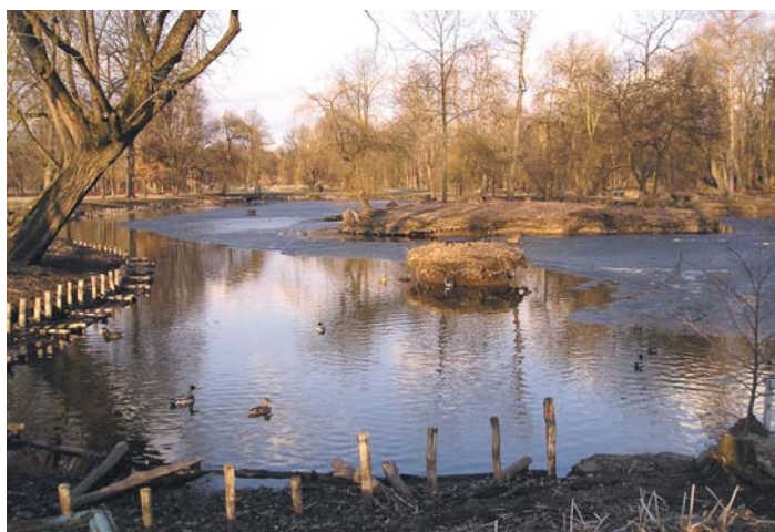
BŘEHY RYBNÍKŮ VE STROMOVCE jsou poškozené a podléhají erozi. Foto: MHMP
